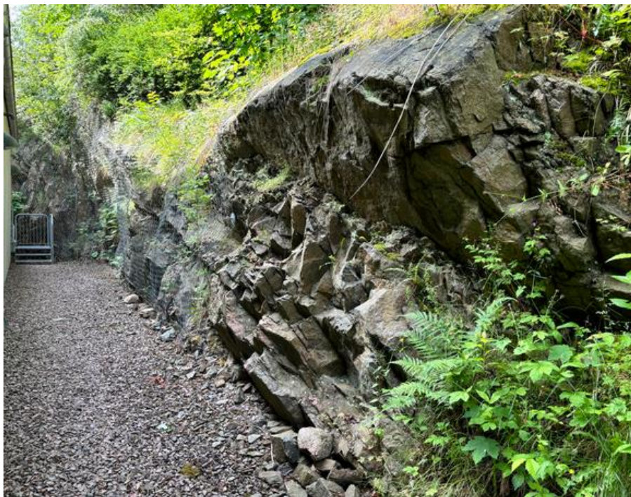
Figur 4 Sprängd skärning mellan ålderdomshemmet och Chalmers teknikpark.
